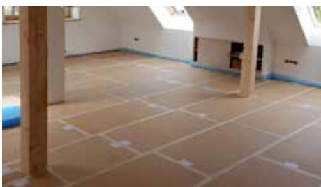
Dachbodenausbau PhoneStar einlagig verlegt
