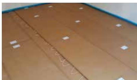
Modulbau - PhoneStar mehrlagig verklebt verlegt
